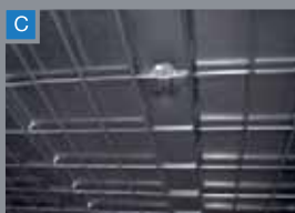
C La rete non saldata, a maglia fitta, evita l'affiorare della ruggine.
