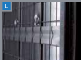
L Sbarre di rinforzo per garantire maggiore resistenza e stabilità alle spinte laterali.
